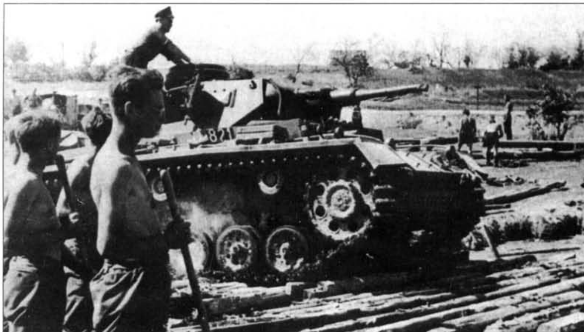
Panzer III пересекает болотистую местность по бревенчатому настилу
